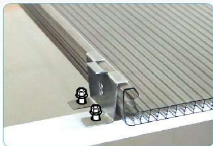
2, 安装不锈钢紧固件 Install the stainless fixer
